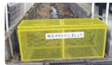
補助金を活用して新設したゴミ収集ボックス(大宮町河辺区)
