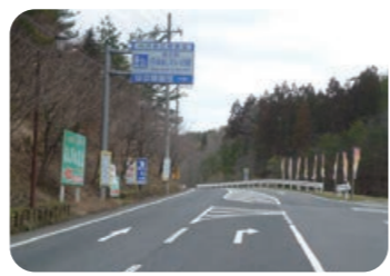
舗装修繕を予定している丹波島津線(弥栄町木橋)
