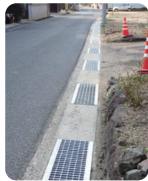
峰山町赤坂丹波線の側溝補修
