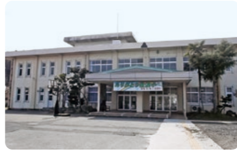
解体撤去を行う佐濃小学校
