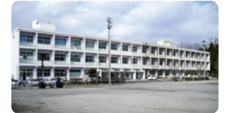
耐震補強工事を行う吉原小学校
