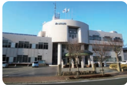
京丹後市役所 峰山庁舎
