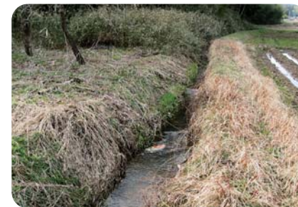
長岡水路（峰山町）
