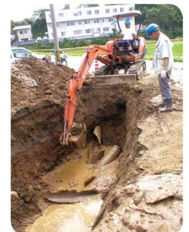
石綿管の老朽化による用水管(パイプライン)の破損
