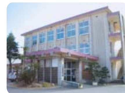
建て替えを予定している網野中学校の管理棟
