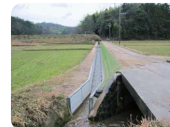
整備された用水路(峰山町矢田)
