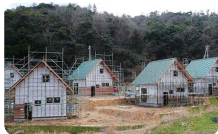
建設が進むクラインガルテン
