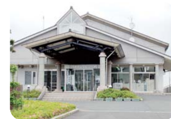
オストメイト対応トイレを 設置するアグリセンター大宮
