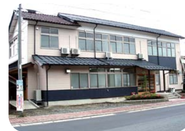
増改築工事が完了した 峰山共同作業所
