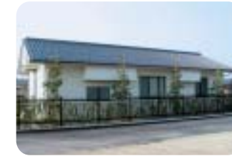
供用開始した 甲山ポンプ場(久美浜)
