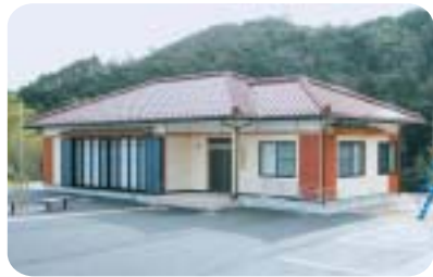
完成した 松岡団地集会所
