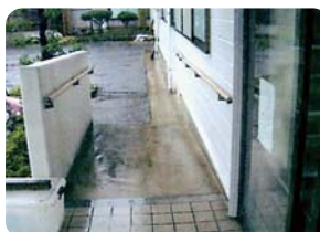
公民館入口にスロープ設置
