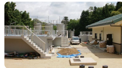
工事が進む善王寺浄水場
