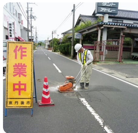
道路補修作業の様子
