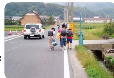
整備中の田井垣線（大宮町）
