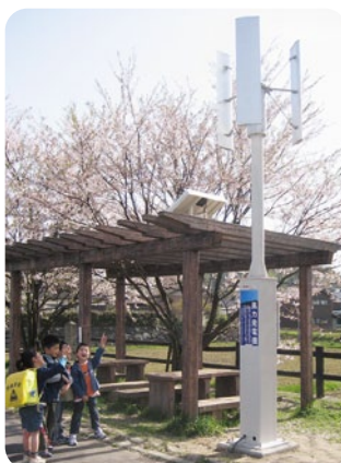
口大野地内の風力発電機
