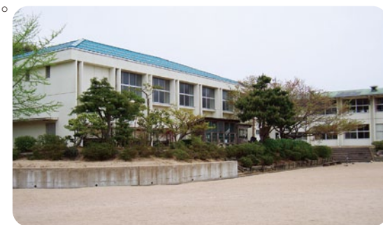
改築予定の神野小学校体育館
