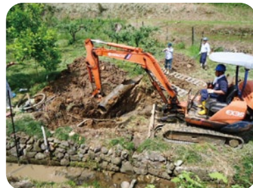
石綿管撤去の様子
