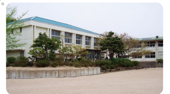
改築予定の神野小学校体育館
