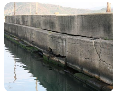
今年度保全工事予定の浅茂川漁港南防波堤
