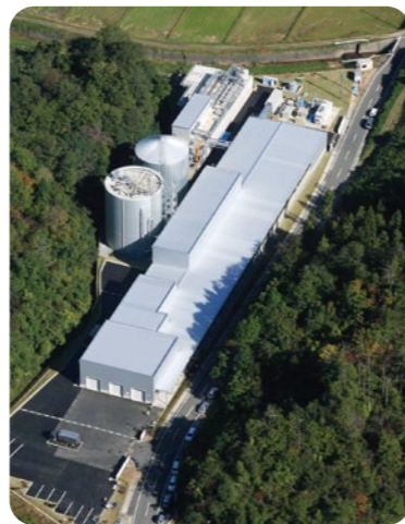
京丹後市エコエネルギーセンター
