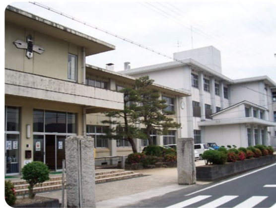
平成25年度校舎改築工事等を予定している高龍中学校
