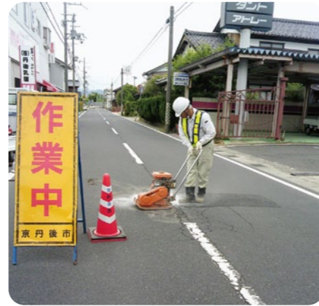
道路補修作業の様子
