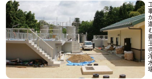
工事が進む善王寺浄水場
