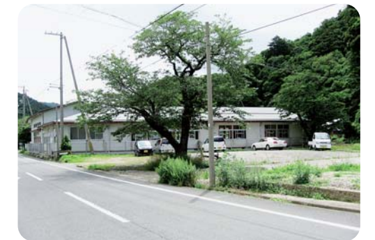
改修予定の上宇川保育所
