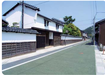
整備中の久美浜一区
