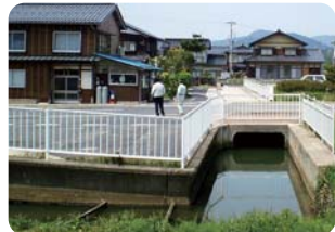
整備予定の排水路
