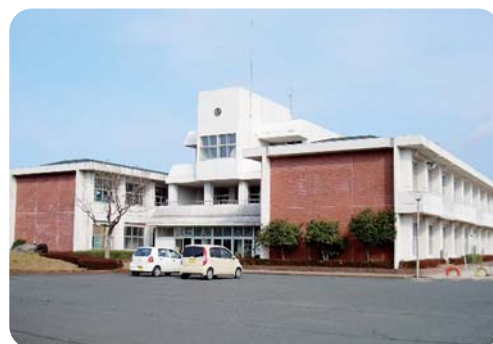
耐震診断を実施する鳥取小学校校舎
