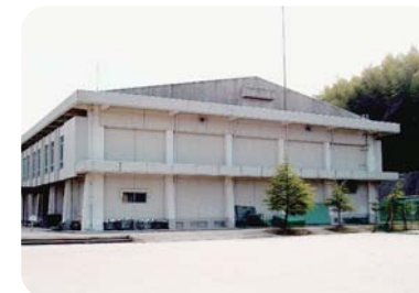
耐震改修を実施する峰山中学校体育館
