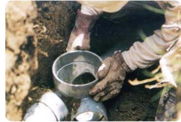
排水設備工事
