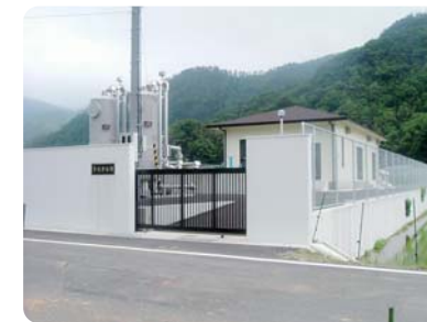
統合事業により建設された宇川浄水場
