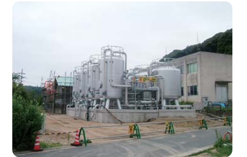
改良工事中の小浜浄水場
