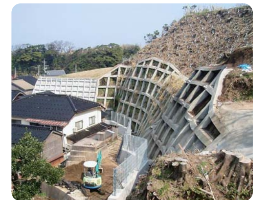
急傾斜地での崩壊対策工事
