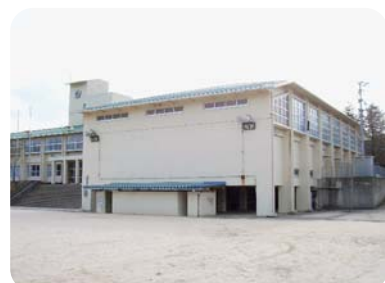
耐震化工事を実施する橘小学校体育館
