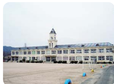
耐震診断を実施する黒部小学校
