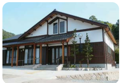
新築された 久美浜町耐ヶ畑公民館
