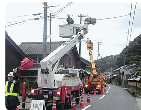
光ファイバ敷設工事
