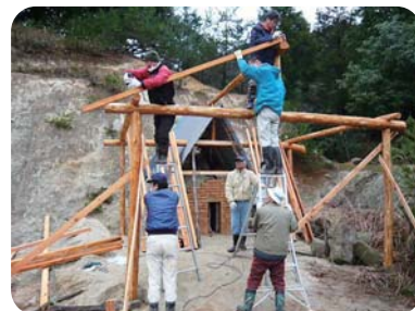
炭焼き釜整備(久美浜町甲坂)
