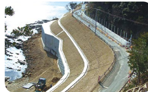
整備中の蒲井旭線(久美浜町)
