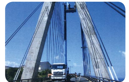
橋りょう点検
