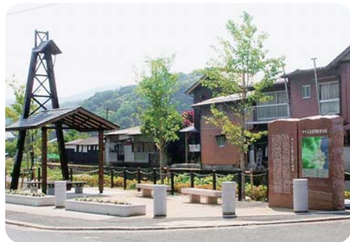
街なみ環境整備を実施している久美浜一区
