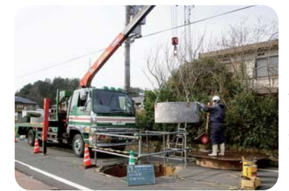
マンホール設置工事
