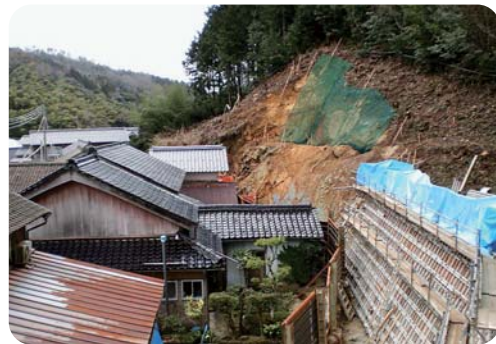
急傾斜地での崩壊対策工事(網野町)
