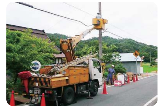
光ファイバ架線工事
