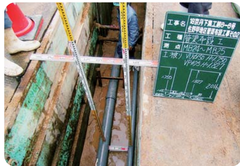
管渠布設工事
