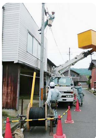
光ファイバ架線工事
