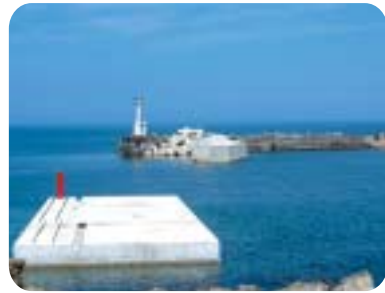
整備中の浜詰漁港
