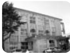
建て替えが予定されている 網野中学校の管理棟
