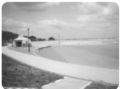
整備中の八丁浜シーサイドパーク
