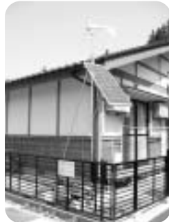
老人福祉施設に設置した 小型風力発電機
