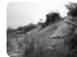
保全工事が急がれる 赤坂今井墳丘墓(峰山町)
