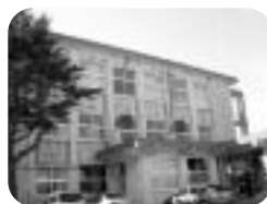
建て替えが予定されている 網野中学校の管理棟
