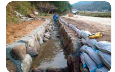
自主施工により生き物に配慮した石積護岸(尉ヶ畑区)
