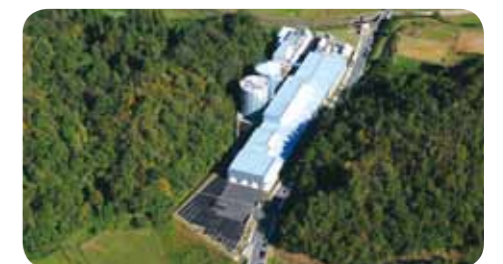
京丹後市エコエネルギーセンター(弥栄町船木)
