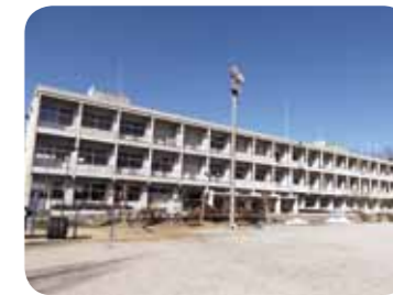
耐震補強工事を行う予定の吉原小学校校舎
