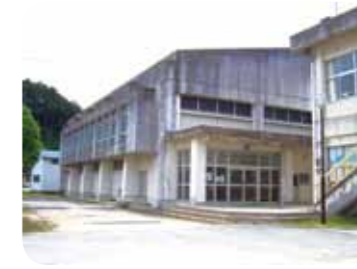
耐震補強工事を行う丹波小学校体育館
