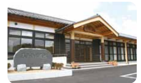
平成24年度に新築した善王寺公民館(大宮町)
