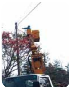
光ファイバケーブルの保守作業
