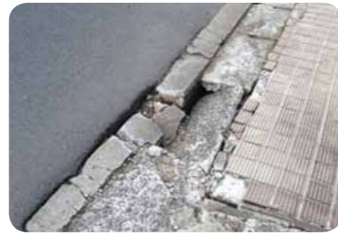
小規模で簡易な道路修繕などは市民局や地域で実施します ※写真の例は溝ふたや側溝の修繕
