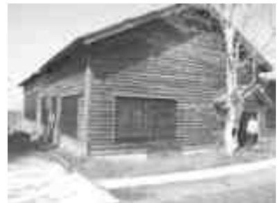
共同作業場に改築する旧袖志分校講堂
