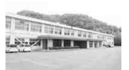
空調設備を設置する大宮南小学校
