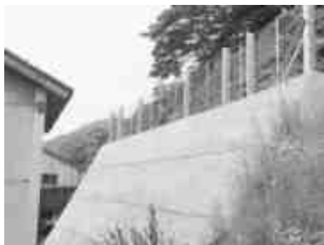
平成26年度に完了した急傾斜対策工事(丹後町間人地内)
