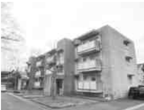
市営住宅堤団地(南棟)
