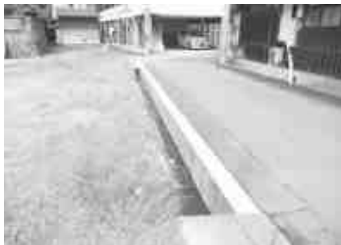
修繕を行った道路側溝
