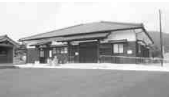
集会施設の新築（甲山区）
