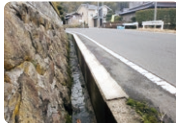
修繕を行った道路側溝
