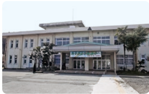
解体撤去を行う佐濃小学校
