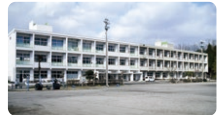
耐震補強工事を行う吉原小学校
