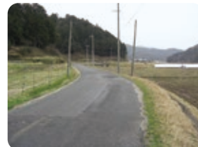
拡幅改良工事を予定している栃谷口馬地線（久美浜町三谷）
