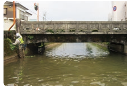
橋梁点検を実施した樋田橋（峰山町杉谷）
