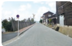
舗装された市道牛揚本線(網野町浜詰)
