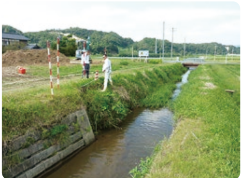
護岸の修繕工事を予定している入山川（弥栄町吉沢）
