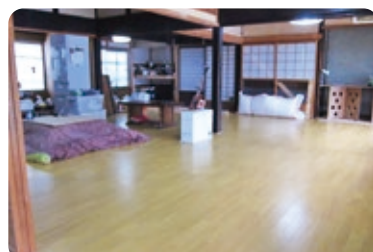
補助金を活用して改修した床（畳からフローリングへ）
