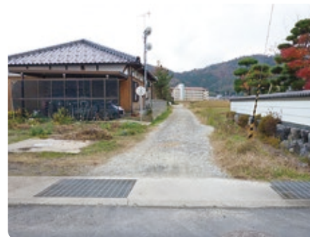
舗装新設工事を予定している福田線（網野町網野）
