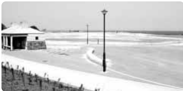
整備中の八丁浜シーサイドパーク
