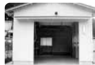
平成16年度に新築した 消防車庫（網野町）
